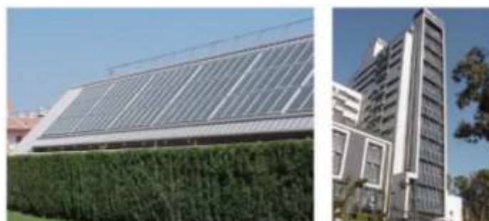
Figura 3E. Ejemplos de integración arquitectónica de grandes instalaciones solares térmicas
