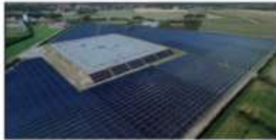
Campo solar térmico con almacenamiento PITEE, Gran, Dinamarca
